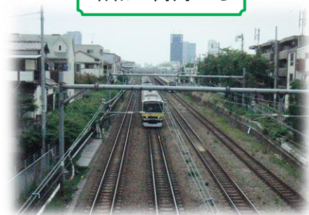
跨線橋から中野駅方面を望む
