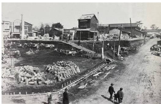
中野駅北口一帯の掘り下げ工事
